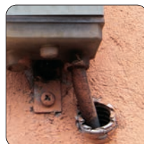
Protezione ingresso tubo corrugato
