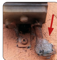
Protezione ingresso tubo corrugato
